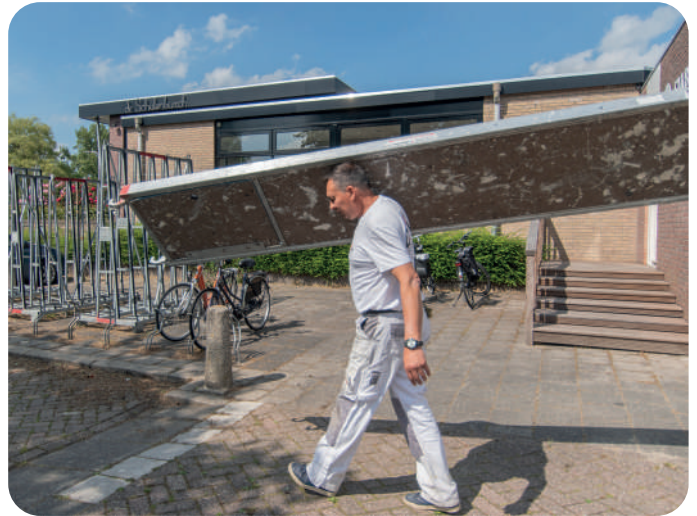
In juni werd geluidswerend glas geïnstalleerd.
