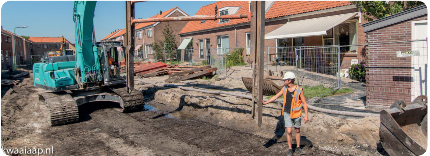
Aanleg van de hoge betonvloer in de Pastoor Schuurmanstraat. Foto door Kees de Kwaastenet.
