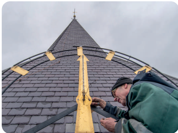
TERUGPLAATSING WIJZERPLAAT AAN DE KANIS
