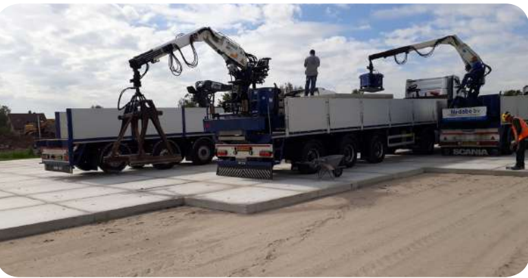
Afbeelding 2 - De tijdelijke parkeerplaatsen worden aangelegd.
