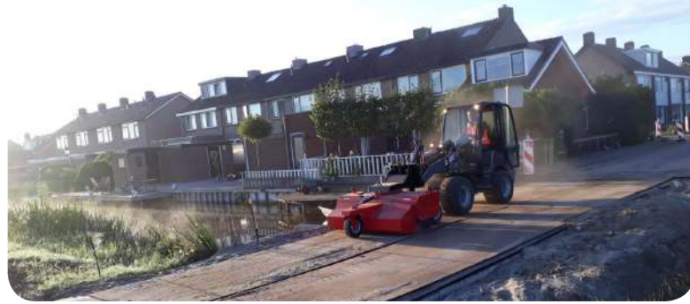
Afbeelding 3 - De tijdelijke dammen zijn gereed!
