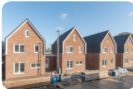
BETON STORTEN IN DE KANIS
