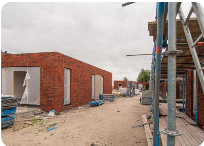
HET MATERIEEL STAAT KLAAR BIJ DE KNOTWILGENLAAN
