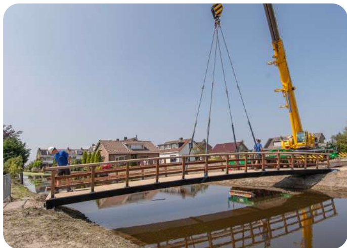
PLAATSING BRUG IN TOEKOMSTIG PARK DE KANIS
