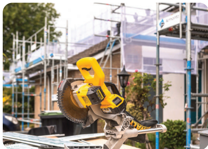
RENOVATIE HUURWONINGEN AAN DE HILD
