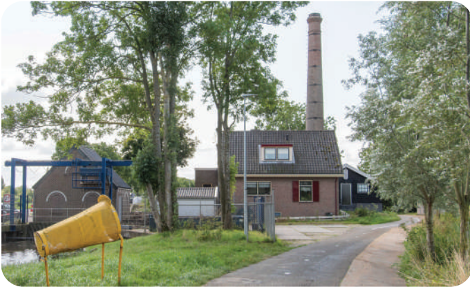
Het fietspad tussen Kamerik en Woerden is aan verbetering toe.
