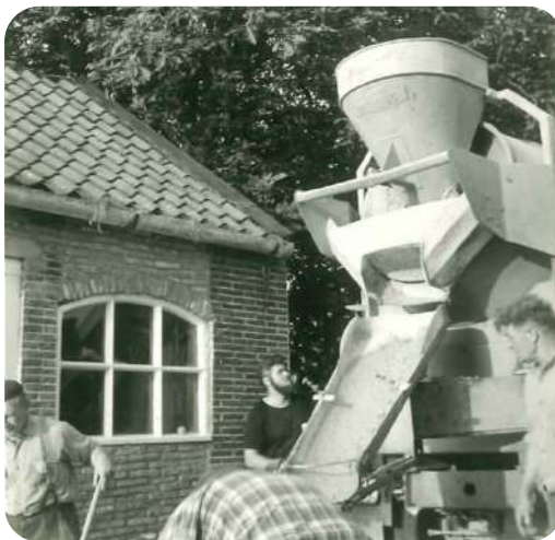
Metselaars aan het werk met de betonauto.
