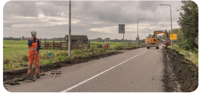
Werkzaamheden aan de N405.
