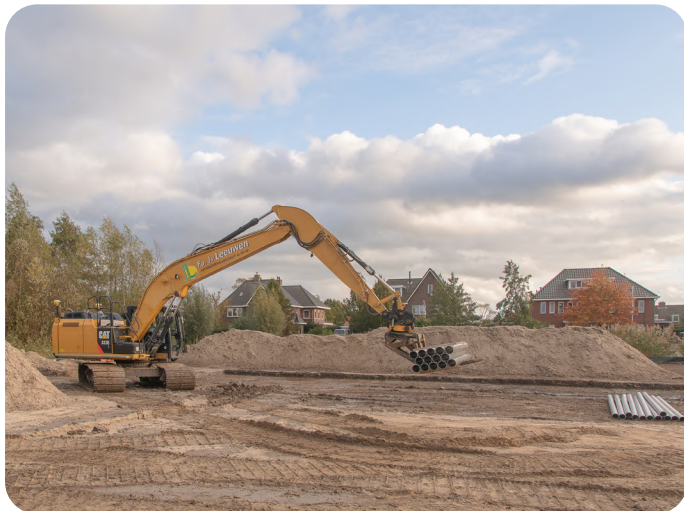
VOORBEREIDEND WERK KNOTWILGENLAAN
