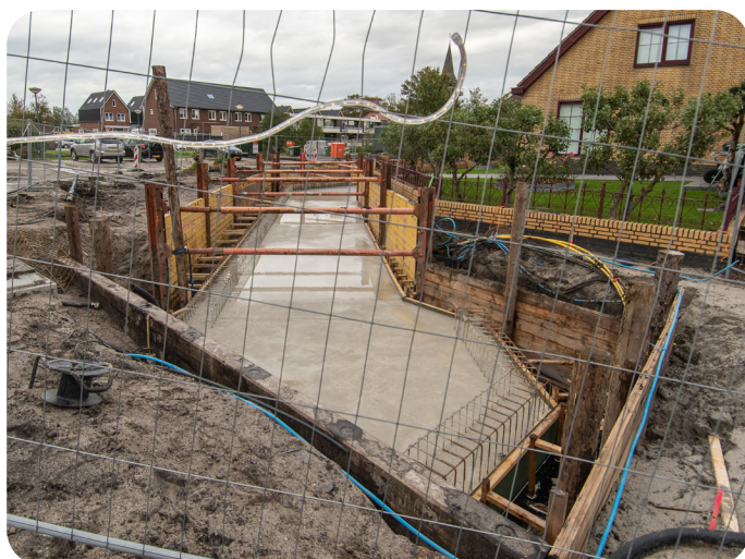
BETONSTORT IN PASTOOR SCHUURMANSTRAAT, KANIS
