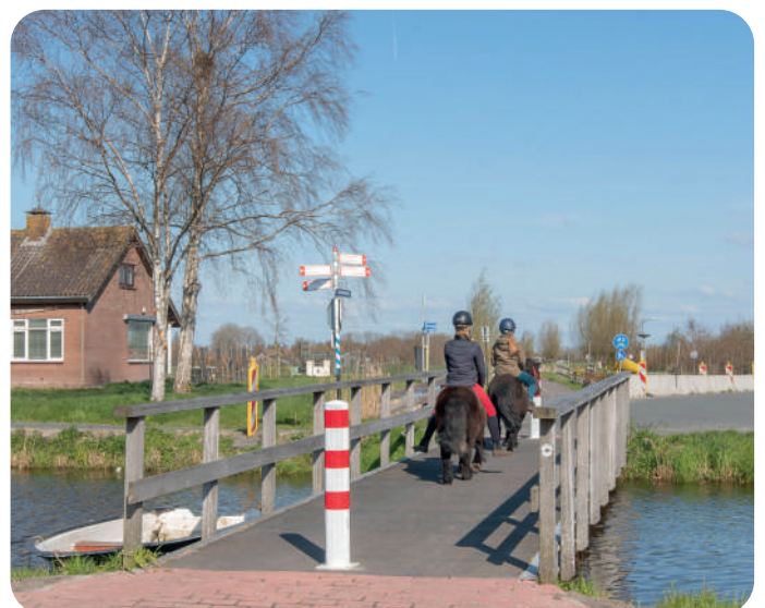
Het Dorpsplatform wil de fietsbrug aan de Kanis graag behouden.
