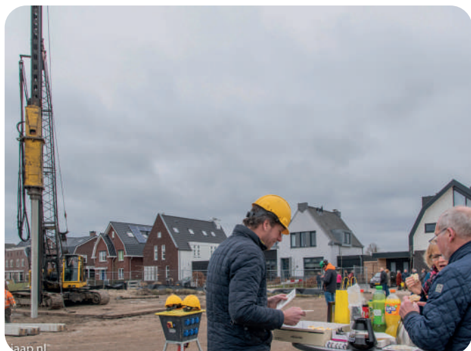
EERSTE PAAL PROJECT KNOTWILGENLAAN GESLAGEN
