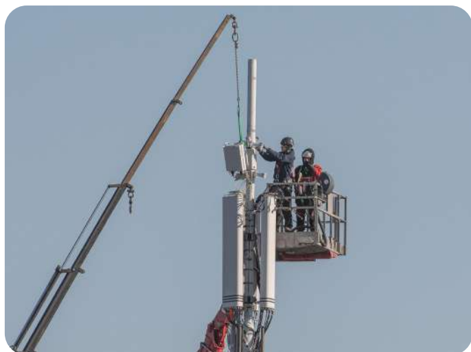
ONDERHOUDSWERKZAAMHEDEN AAN DE ZENDMAST
