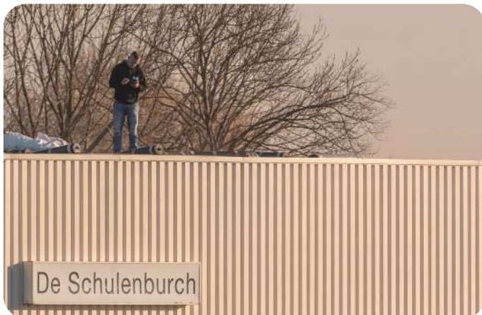
De gemeente heeft de stormschade aan het dak betaald. Foto door Kees de Kwaasteniet.
