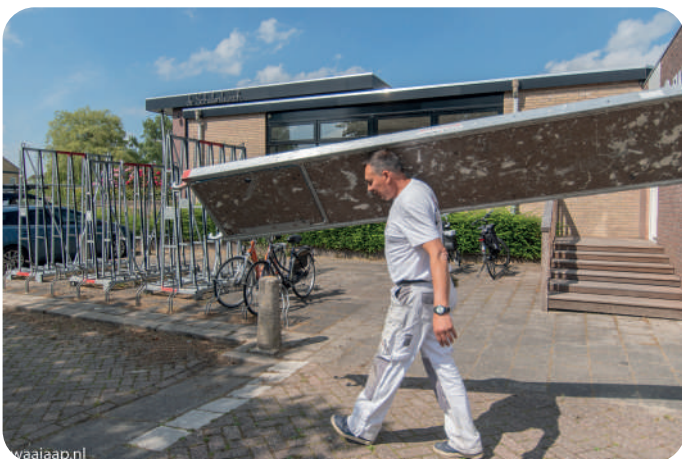
NIEUW GELUIDSWERENDGLAS IN DE SCHULENBURCH
