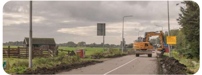
De werkzaamheden aan de N405 zijn volgens het Dorpsplatform niet geheel naar wens uitgevoerd.
