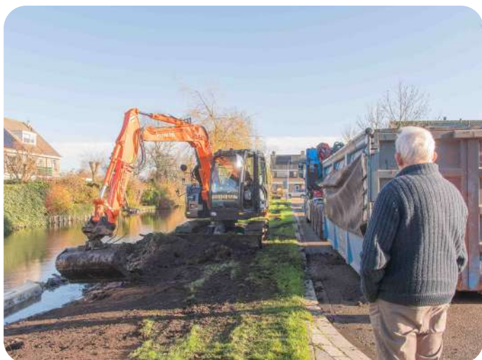
WERKZAAMHEDEN VOOR NATUURLIJKERE SLOOTKANT OP DE DEEL
