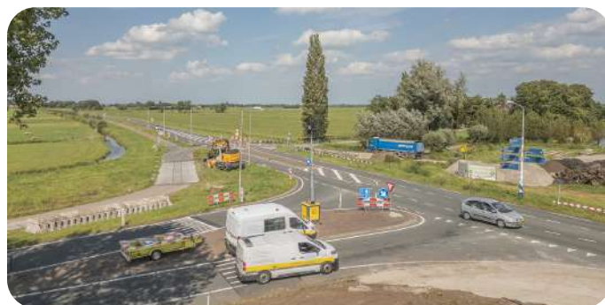
De voorbereidingen aan de Enschedeweg zijn begonnen.
