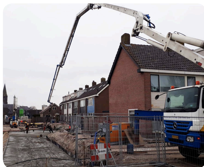
Afbeelding 3 - Het beton van de vloer wordt gestort in de Leeuwerikstraat
