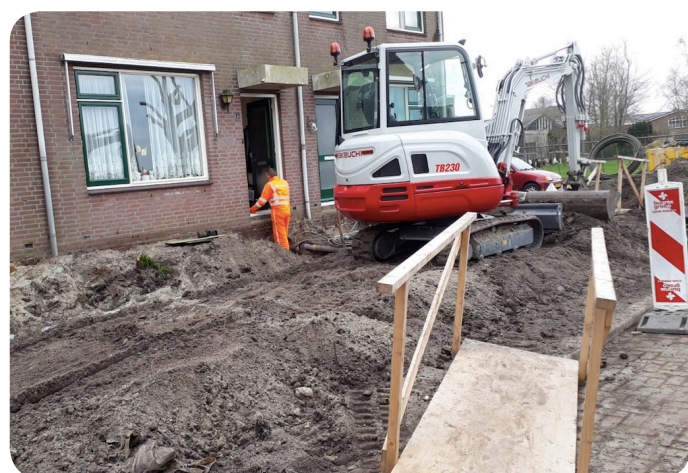
Afbeelding 2 - In de Meerkoetstraat zijn de huisaansluitingen vervangen
