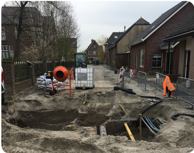
Afbeelding 4 - De laatste rioleringswerkzaamheden in het Pastorielaantje
