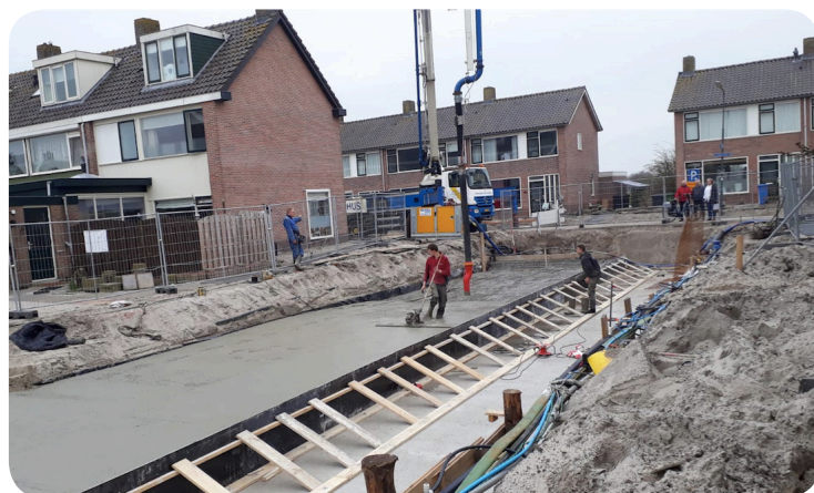
Afbeelding 6 - Een deel van de betonvloer wordt gestort in de Leeuwerikstraat
